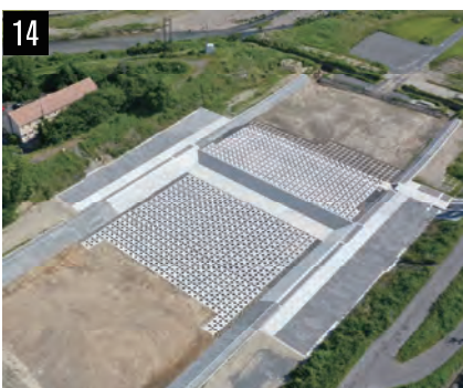
14 二級河川新川河川改修工事(下流低水護岸)
