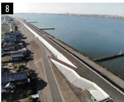
8 木曽川松蔭上流高潮堤防嵩上工事 源線輪中工区
