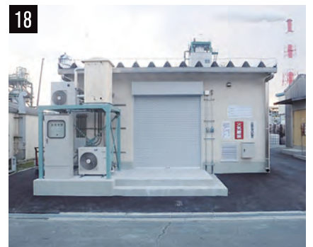
18 危険物倉庫 新築
