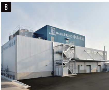
8 水産工場 新築
