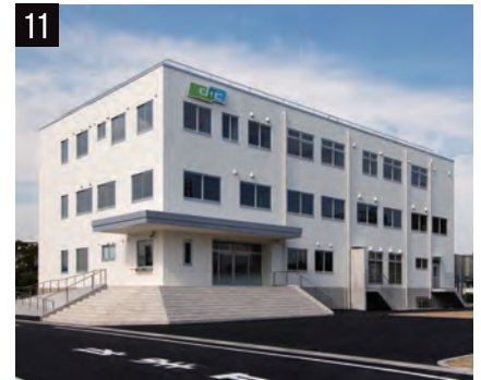
11 事務所棟 新築
