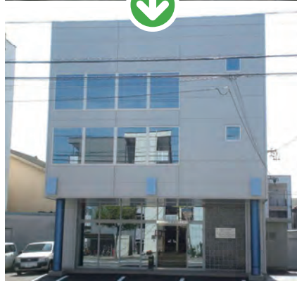
8 事務所 耐震補強・内装改修工事
