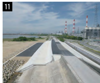
11 鈴鹿川石原高潮堤防工事
