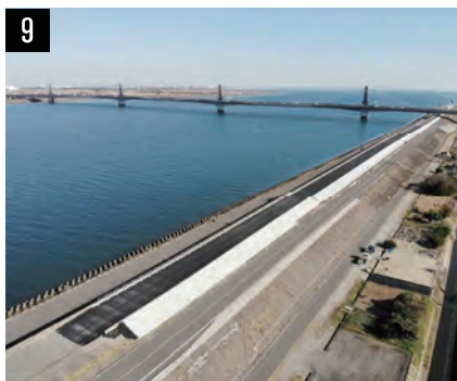
9 木曽川松蔭上流高潮堤防嵩上工事 松蔭工区
