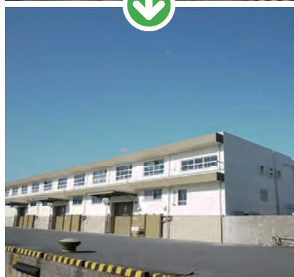
7 事務所 一部解体・撤去、全面改修
