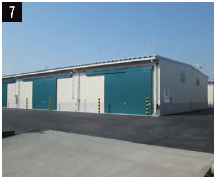
7 危険物倉庫 新築
