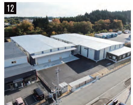
12 工場・倉庫 新築
