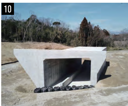
10 北勢バイパス西坂部南地区改良工事
