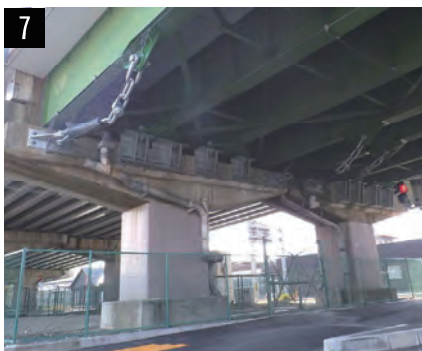
7 258号安永高架橋補強工事
